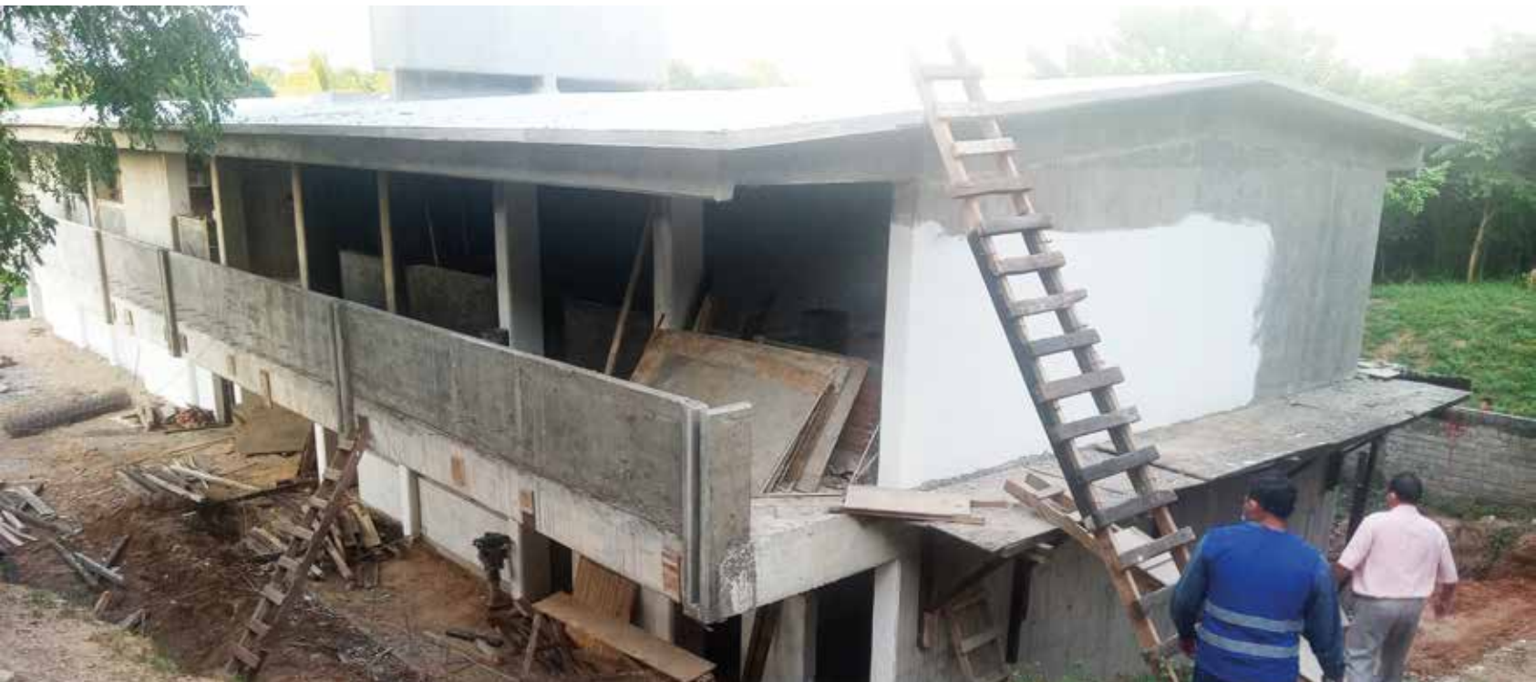
Supervisión de obra financiada con aportaciones del gobierno federal
